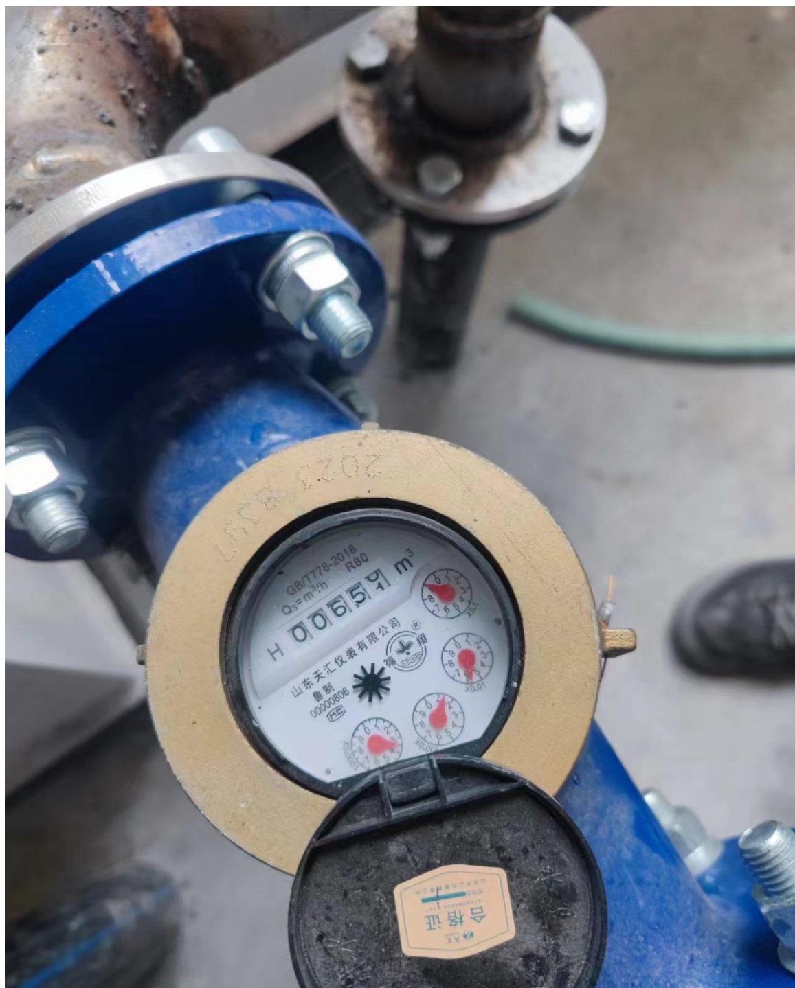
图7-1 现场测试照片
